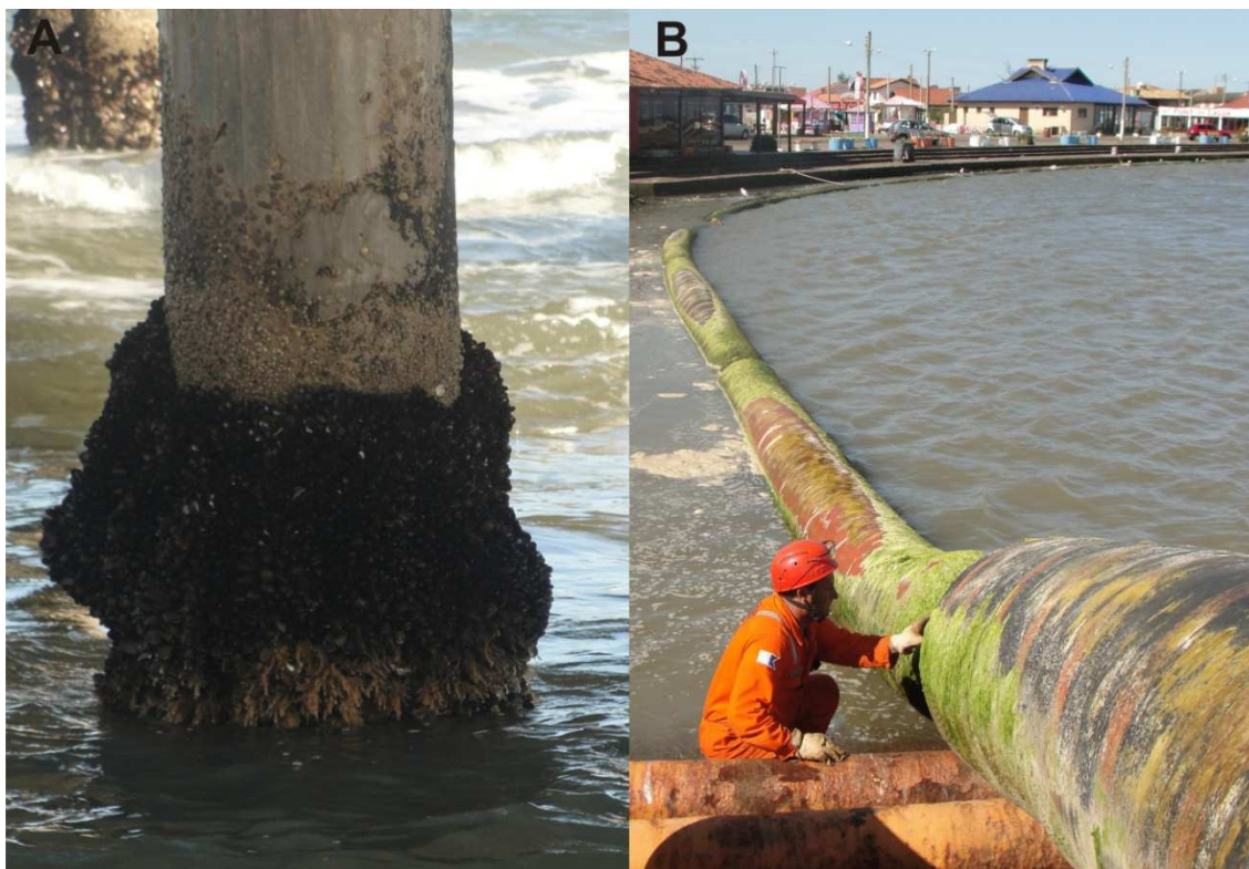
Figura 5 – Fotografias apresentando alterações estéticas e aumento de peso em estruturas oceânicas antrópicas causados pela colonização de organismos nos substratos consolidados artificiais. A. Pilar da Plataforma de Pesca de Tramandaí, Rio Grande do Sul, Brasil (Foto: Agostini, 2011). B. Mangote da monoboia de oleoduto da empresa Transpetro (Petrobrás S.A.) de Tramandaí, Rio Grande do Sul, Brasil (AGOSTINI, 2011).
